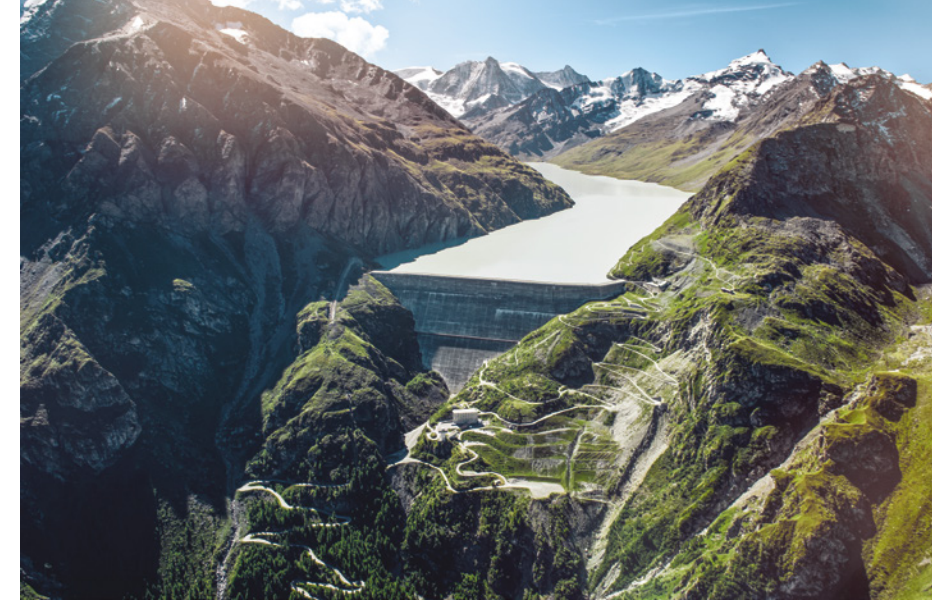
La Grande-Dixence, le barrage-poids le plus haut du monde avec ses 285 m, permet d'alimenter plus d'un demi-million de ménages en électricité.
